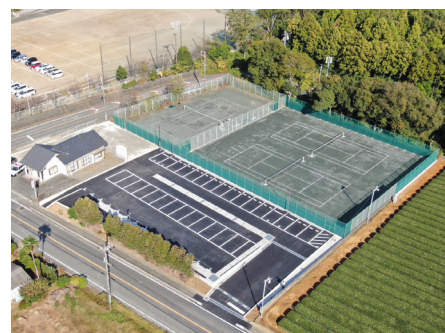
磐田市で表彰を受けた現場(向陽学府小中一体校テニスコート・駐車場)
