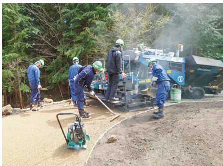
田貫湖周遊道路の舗装工事
