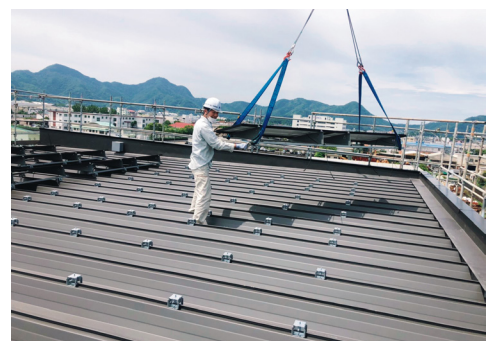
太陽光発電システムの取付工事
